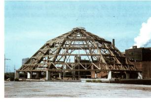
La madera fue seleccionada en este proyecto por la resistencia contra atmósferas agresivas como es el caso de un almacén de carbón. Además era prevista una grúa suspendida de 85 m de longitud con capacidad de carga de 200 t. La estructura se realizó con barras rectas, las cuales permiten una transmisión de cargas en línea directa. Este sistema es más económico, a pesar del número de nudos, debido a su realización con los tecnicismos modernos (clavos estriados, broches...).
